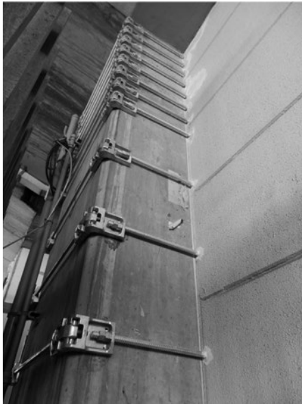
図7 スリムRBによる耐震補強
