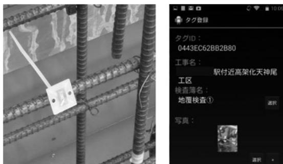
図10 構造物管理用ICタグと支援ツールの画面
