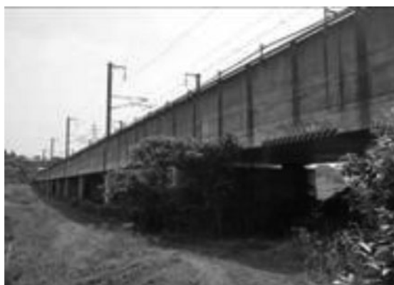
図8 東北新幹線 金ヶ瀬橋梁（白石蔵王～仙台間）
