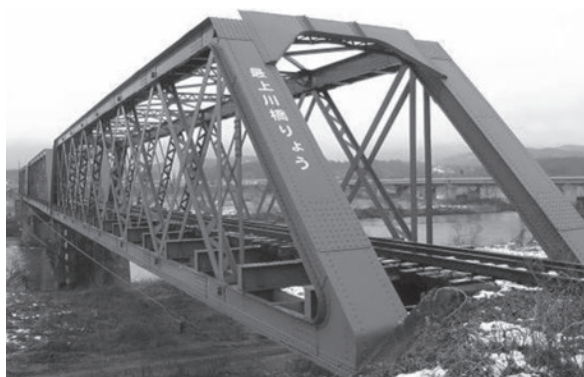
図1 長井線の最上川橋梁(1889年建造、1923年移設)
