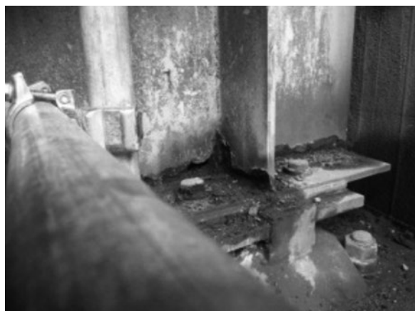
図2 腐食の例
