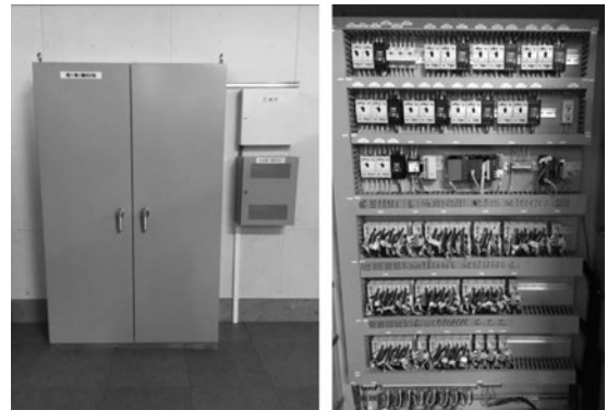
図8 計測機器類設置の状況（左図：測定盤外観、右図：測定盤内部）
