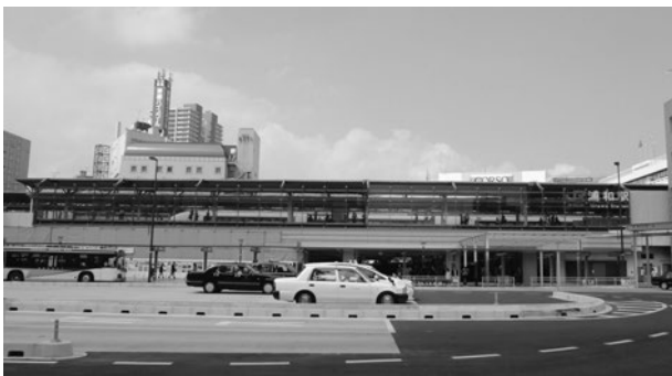
図7 浦和駅全景（東口側より）
