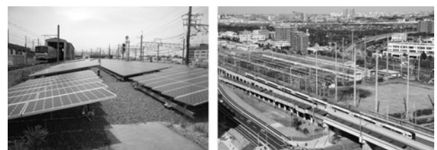
図7 京葉車両センターPV設置状況
