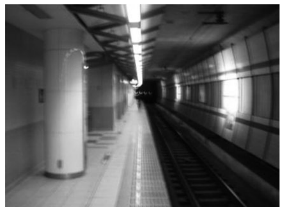
図8 地下駅ホーム(仙石線 仙台駅)
