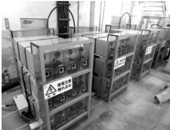
図3 Ni-MH貯蔵装置設置状況
