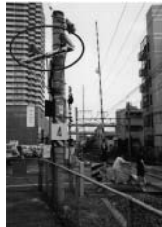
図5：カメラの取付状態
