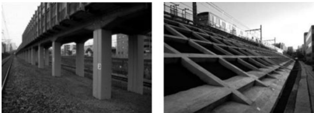
写真 大規模地震対策(高架橋の耐震補強・盛土補強)
