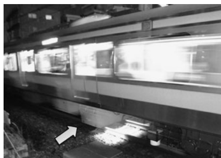
図6 営業列車での線路点検
