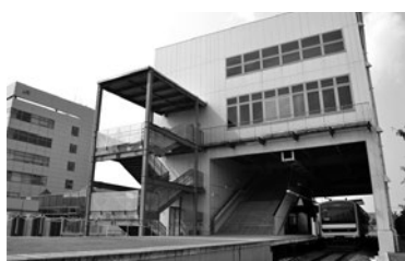
図9 Smart Station実験棟外観
