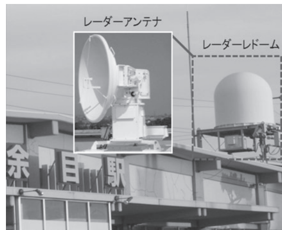
図1 羽越本線余目駅屋上に設置されたドップラーレーダー
