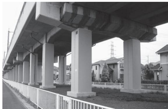
図2 耐震補強実施後の高架橋柱
