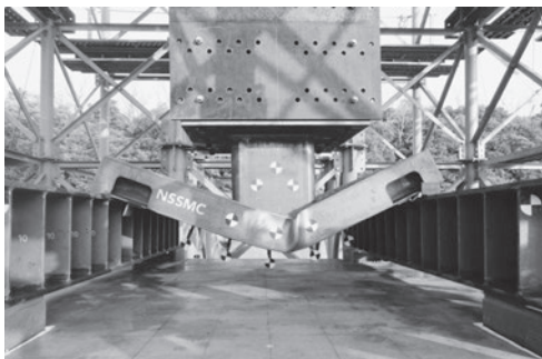
吊荷の落下状況(ケース4)
