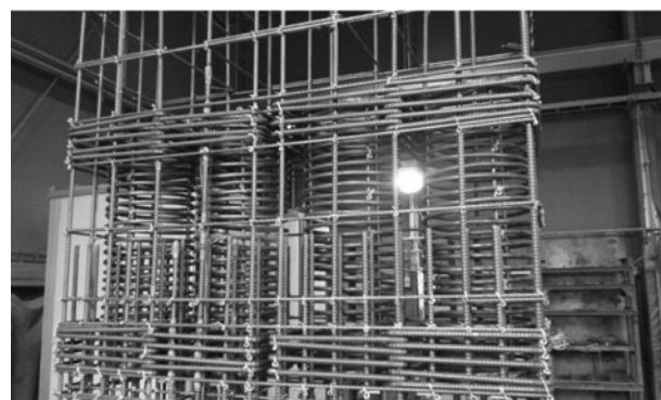
図4 試験体配筋状況
