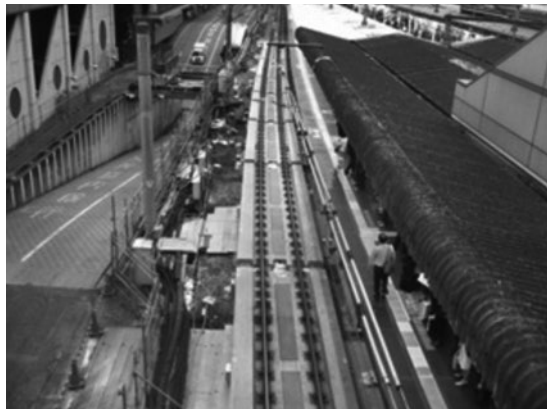
図11 PC工事桁設置状況
