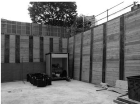
図2 斜め土留め工を用いた掘削工事現場
