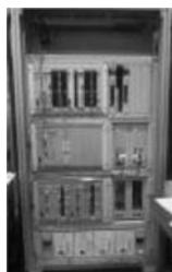
図15 地上装置 (中央+駅) 中込駅設置
