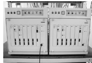
図24 統合型踏切制御装置
