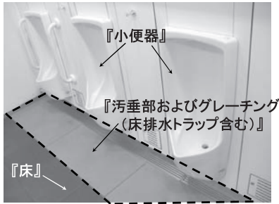
図4 臭気発生箇所のエリア分け
