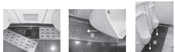
図9 モルタル製の側溝 (左よりA駅、O駅、U2駅)
