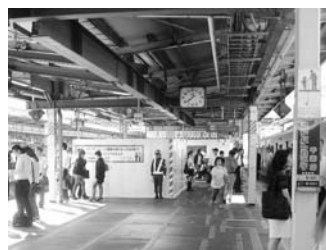
図17 C駅仮囲い設置箇所写真
