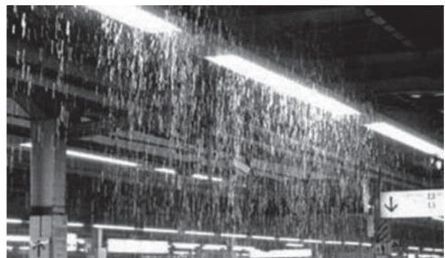
図3 集中豪雨による漏水の例
