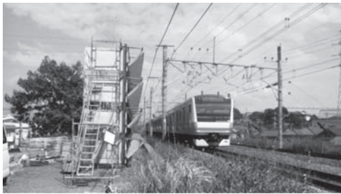
図10 改良型遮音工設置（仮設）状況
