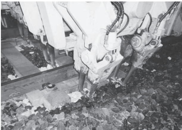
図8 グリッドマクラギ部のMTTつき固め
