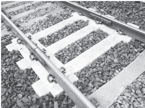
図5 試験敷設したグリッドマクラギ
