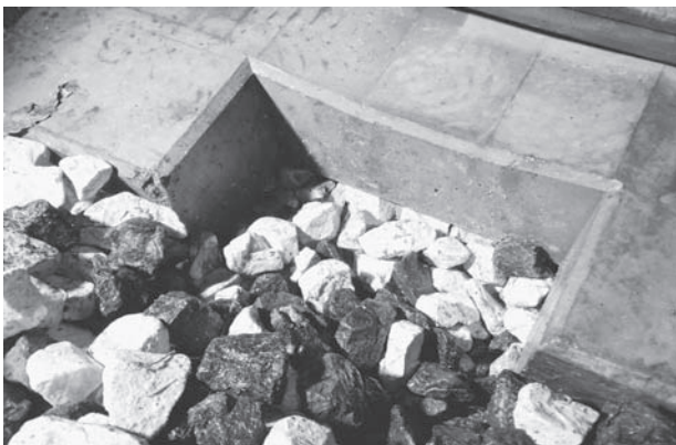
図9 MTTによる砕石かき込み状態の確認
