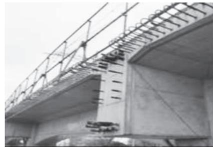
図1 施工継目部例
