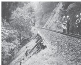
図1 土工設備の目視検査
