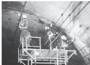
図2 トンネルの打音検査
