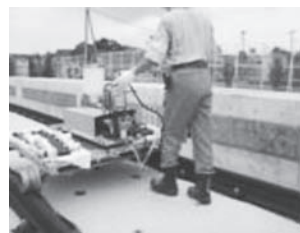
図8 施工試験状況
