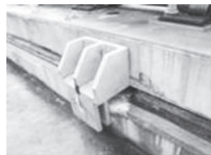
図12 増強策① (インサート孔部取付)
