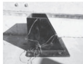
図13 増強策② (路盤コンクリートがない場合)
