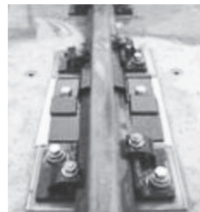
図1 レール転倒防止装置
