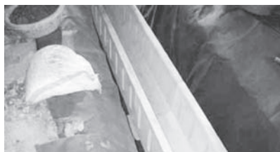
図8 排水設備（排水こう）
