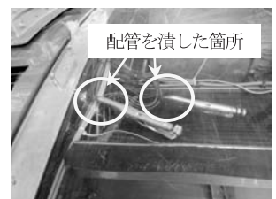
図5 配管を潰した状態
