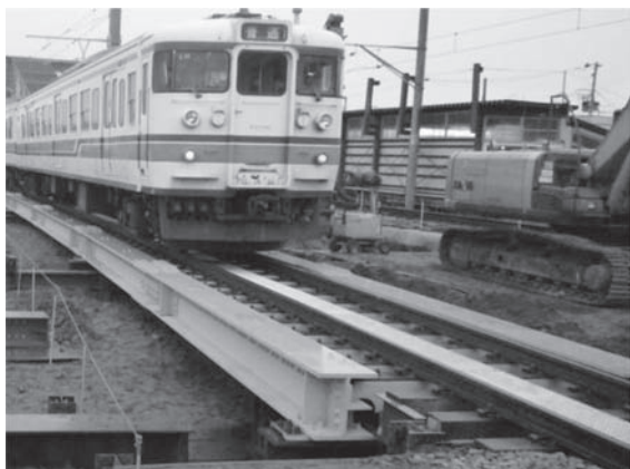
図1 マクラギ抱き込み式工事桁
