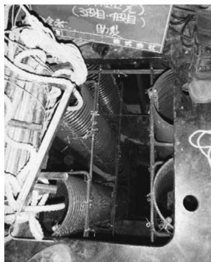
写真5 スパイラル鉄筋による柱内部補強状況
