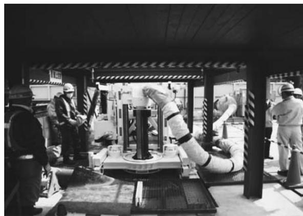
写真2 超低空頭場所打ち杭機
