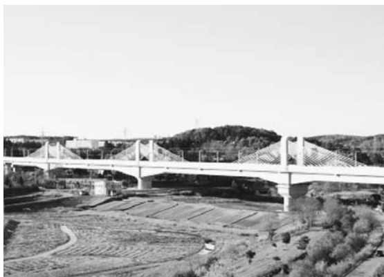
写真9 三内丸山架道橋 4)
