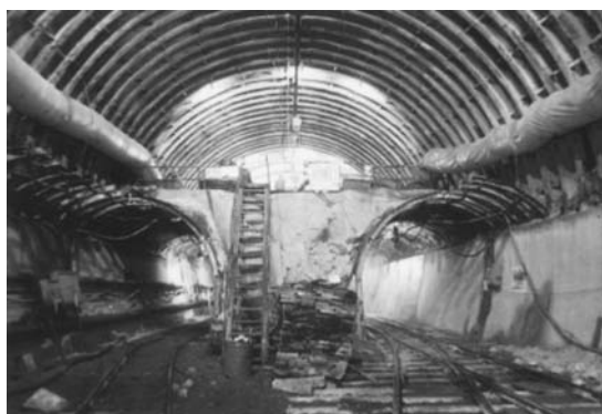
写真4 青函トンネル工事 1)
