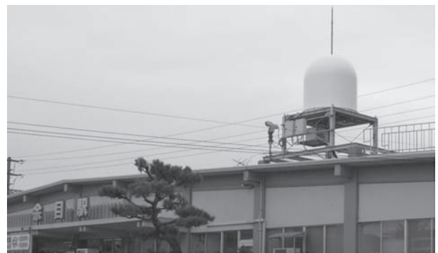
図1 余目駅屋上に設置されたドップラー気象レーダー
