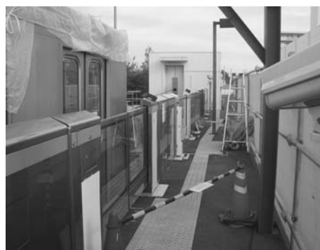
図17 連続稼働試験風景
