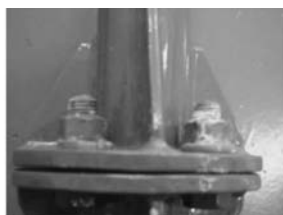
図12 ボルト締結部
