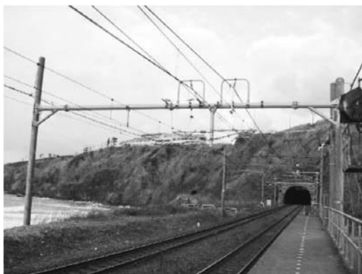
図13 敷設した塩害区間用ビーム
