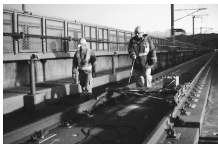
図9 トラックマスターによる軌道変位測定作業
