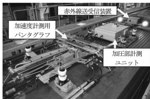
図8 MUE-Trainに搭載された架線状態監視装置の外観
