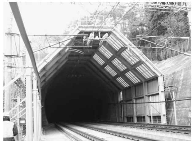
図12 試験施工(設置完了)
