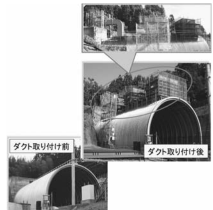
図6 現地試験（ダクト取付け状態）
