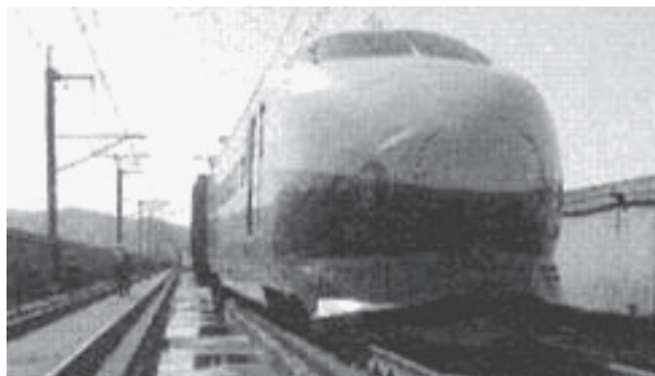
図1 脱線した200系新幹線電車の先頭車
