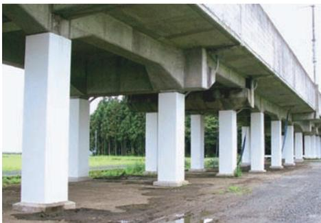
図3 高架橋の耐震補強
