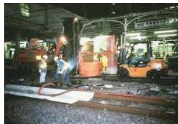
図9 線間における鋼管杭打設状況
