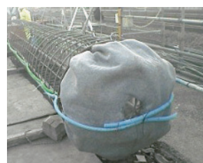
図1 先端プレロード場所打ち杭
