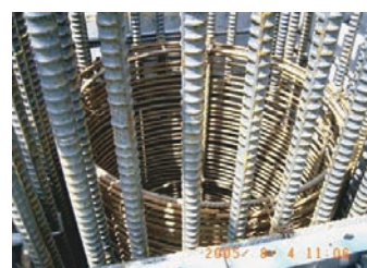
図3 内巻きスパイラル柱配筋状況
