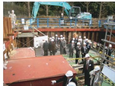
図5 地盤切削JES工法公開施工試験状況
