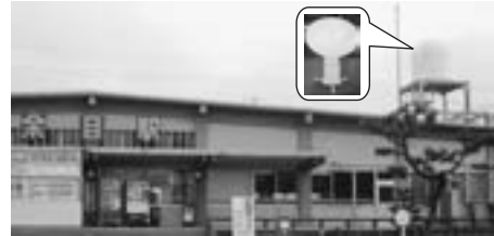
図7 余目駅屋上に設置された気象ドップラーレーダ (吹き出し内は収納されているアンテナ)
