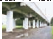
脱線現場付近高架橋の耐震補強状況
