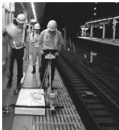
図13 ホーム上測定状況
