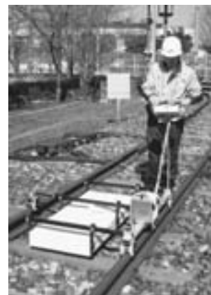
図4 可搬型線路下空洞探査装置による測定状況
