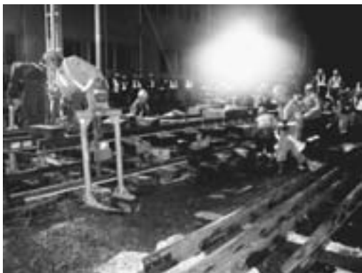
図17 試験敷設（施工中）
