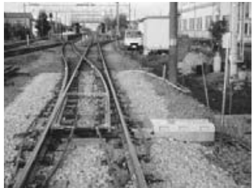
図18 試験敷設完了後
