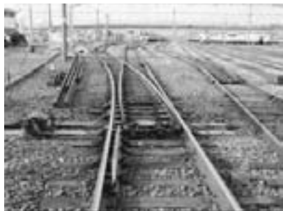
図1 側線用弾性分岐器
