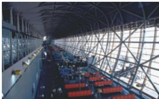
環境技術では、天井に空調機械を一切使っていないオープンエアダクトというものがあります。空気の流れを制御する方法で同時に間接照明の反射板ともなり、天井部には照明器具が一切ありません。開港翌年の1月に阪神淡路大震災を受けた際、震源から27kmに位置し、500Gal程度で揺れたにも関わらず、一切傷つきませんでした。下からアッパーライトで間接照明をすることで照明器具がなく、空調機器もないため、落下物のない屋根構造となっており、軽量に造り上げられています。技術力を集約することで、非常にヒューマン、かつ、ある種のエレガンスを持った建物を造れるのです。
