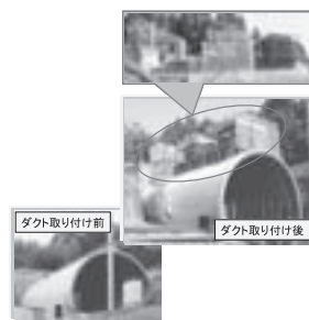
図12 現地試験(ダクト取り付け状態)
