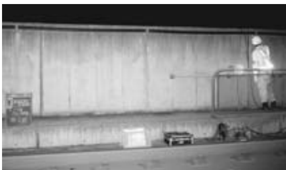
写真4 防音壁現況事前調査状況
