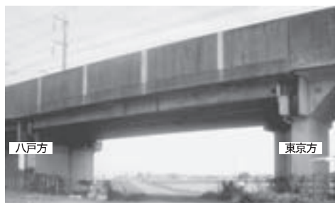
写真11 防音壁剛性増加工法（第1段階）終了状況
