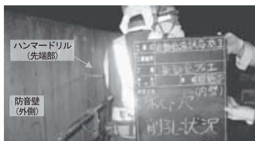
写真5 防音壁削孔状況
