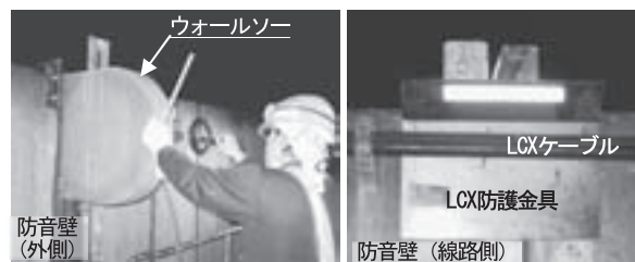
写真6 防音壁切断状況
