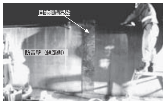
写真8 防音壁鋼製型枠設置状況
